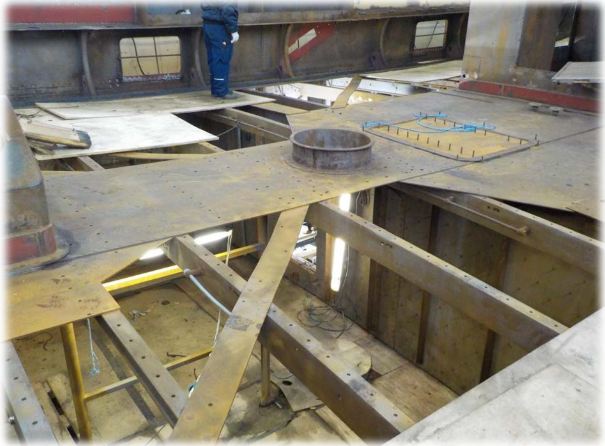
Billede fra renoveringen af Georg Stage II i 2017. En dybdegående skibsrenovering er et stort arbejde, men det kan lade sig gøre.
